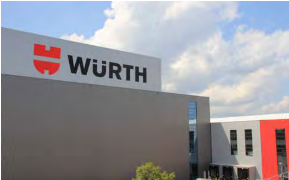
Das neue Logistikzentrum der Würth Industrie Service GmbH & Co. KG
